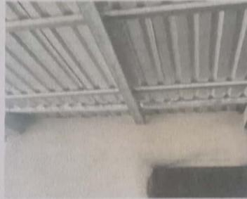
Foto 2: SUSTITUCION DE LAMINA POR LAMINA GALVANIZADA EN COCINA
